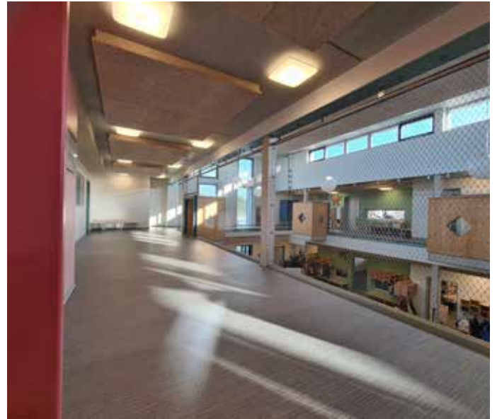
Abb.: Oberlichtbänder in den Außenwänden führen zu einer effektiven Belichtung des zentralen zweigeschossigen Forums.
