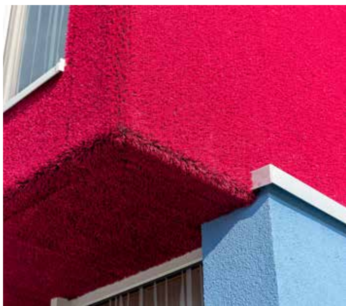
Abb.: Einer der Kuben wurde mit einem farbigen Kunstteppich von Tisca verkleidet. Deutschlandweit ist es die erste Ausführung des Materials an einer Fassade, da das Material normalerweise als begehbarer Außenteppich dient.
