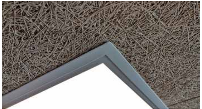
Abb.: Troldekt-Akustikplattenfelder bilden einen bewussten Kontrast zu den Ort-betondecken. Tageslicht- und präsenzabhängige Bewegungsmelder ermöglichen eine effiziente Beleuchtung.
