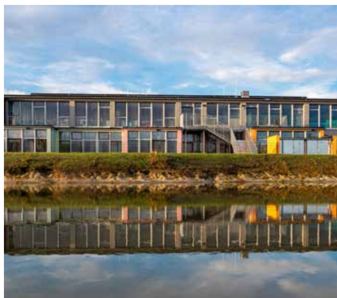
Abb.: Die Gebäudehülle wurde energetisch so optimiert, dass ein Passivhausniveau erreicht wurde. Das Verhältnis von Außenfläche zu Volumen ist durch die kompakte zweigeschossige Bauweise optimiert.
