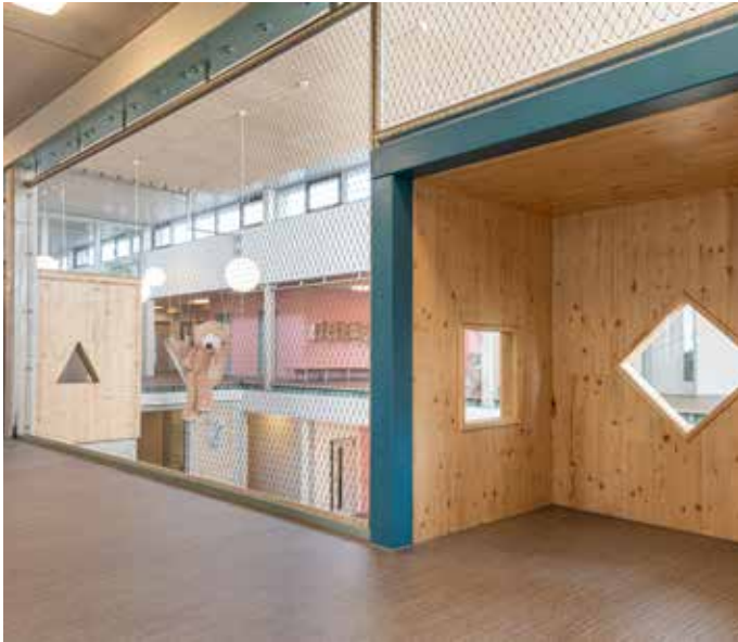
Abb.: Um den Tageslichteinfall nicht zu beeinträchtigen, wurden statt Geländer Edelstahlnetze montiert, die zusätzliche Blick- und Sichtbezüge schaffen.
